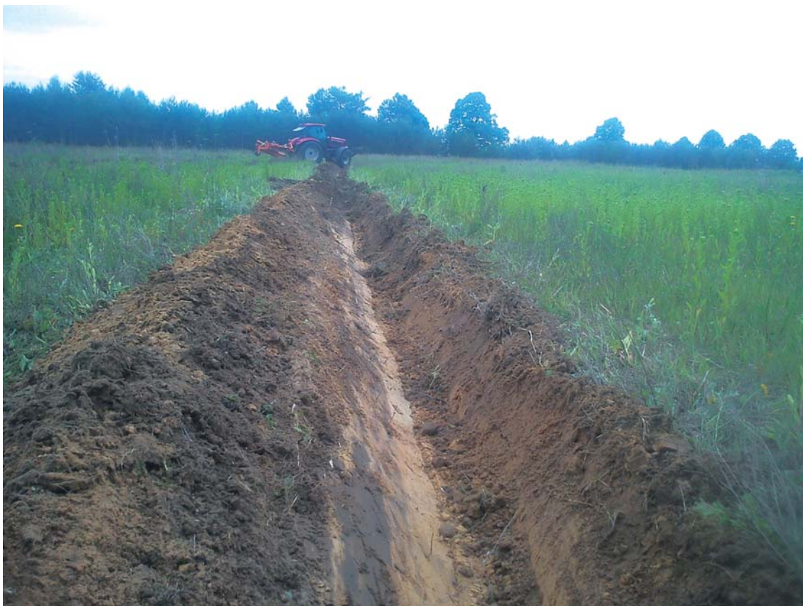
Równiarka może służyć do oczyszczania i pogłębiania przydrożnych rowów, a także kształtowania niewielkich skarp
