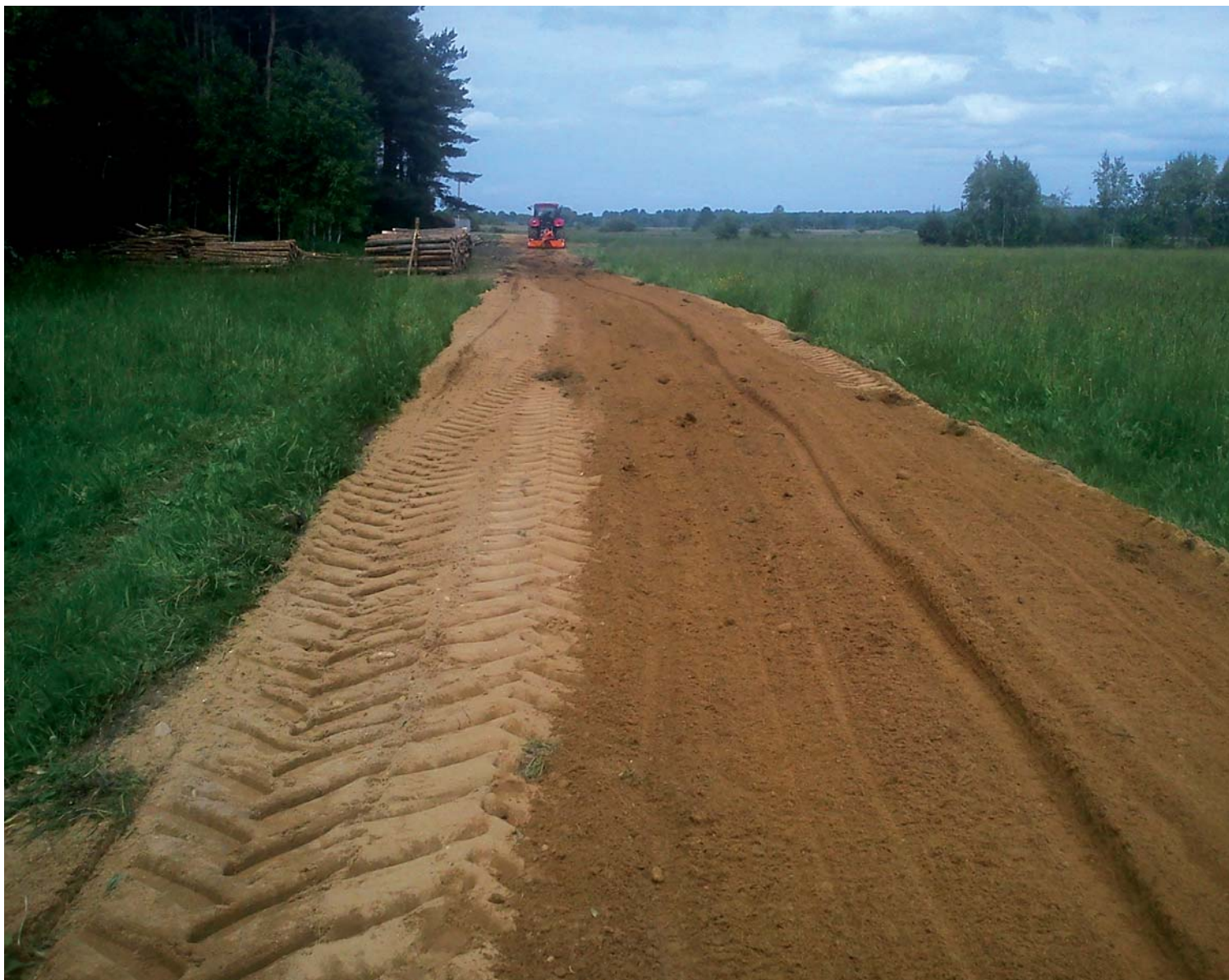
Droga wyrównana równiarką PRONAR RD-Z24
