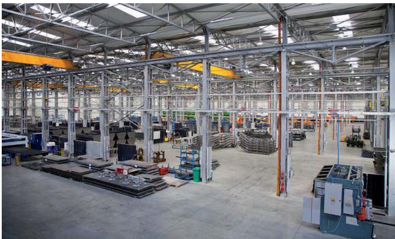
Wnętrze oddanego do użytku zakładu w Siemiatyczach
